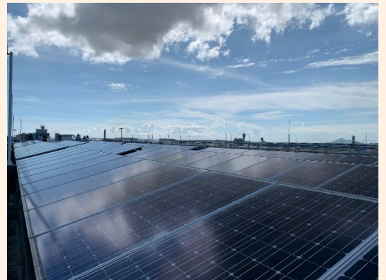
圖 5-5：在天台安裝的太陽能光伏板
