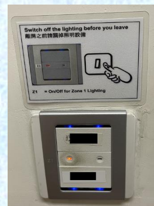
圖 5-4：提醒使用者在離開前關掉所有照明設備的告示
