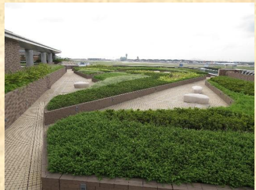
圖 5-6：設置綠化天台，有助降低 頂層室溫
