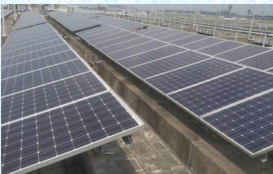
圖 5-5：民航處總部天台的 太陽能光伏板
