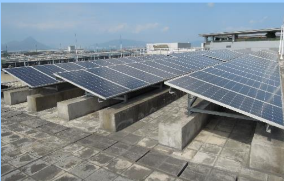
圖 5-6：民航處總部天台的 太陽能光伏板
