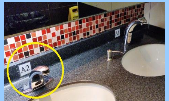
圖 5-14：在更換損壞水龍頭時，選用節水效益較佳的型號
