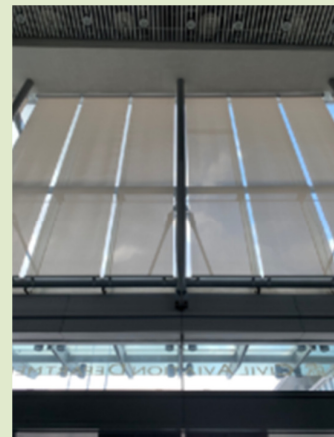
圖 5-5：民航處總部中庭的電動百葉簾 有效阻隔太陽光
