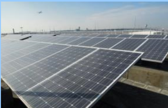
圖 5-6：民航處總部天台的 太陽能光伏板
