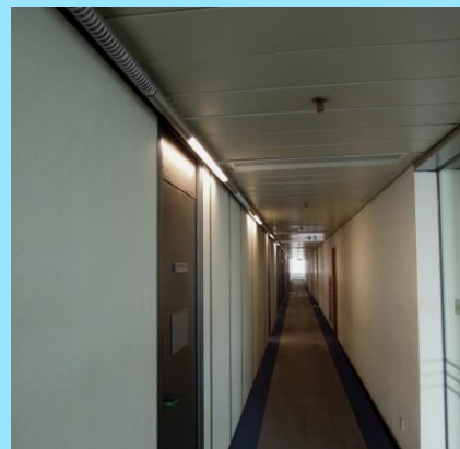
圖 5-2：相間地拆除走廊的熒光管
