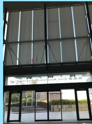
圖 5-5：民航處總部中庭的電動百葉簾有效阻隔太陽光
