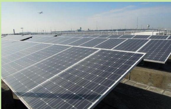
圖 5-6：民航處總部天台的太陽能光伏板
