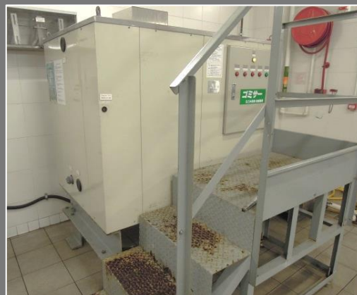
圖 5-12：民航處總部的廚餘分解系統
