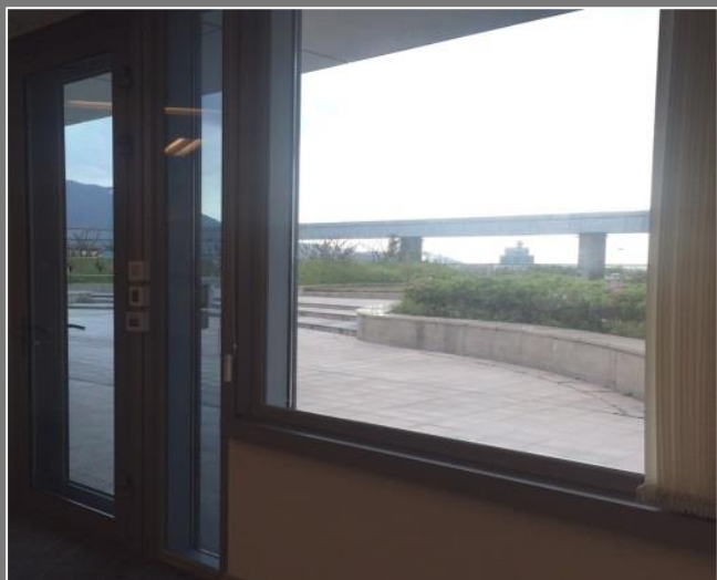
圖 5-5：玻璃面貼上隔熱膜，有效阻隔太陽光照射辦公地方的例子（右邊的玻璃沒有貼上隔熱膜）
