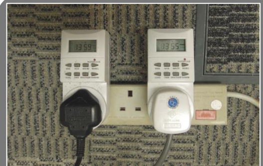
圖 5-4：連接至影印機的節能計時器
