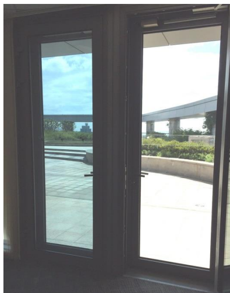
圖 5-5：玻璃面貼上隔熱膜，有效阻隔太陽光照射辦公地方的例子 (左邊的玻璃門貼上了隔熱膜)
