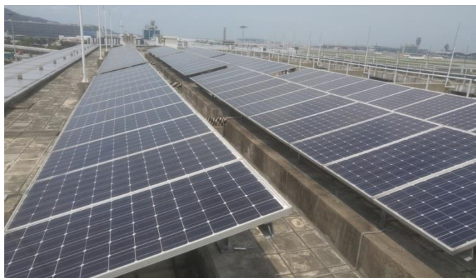
圖 5-6：民航處總部天台的太陽能光伏板
