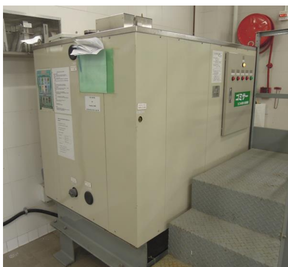
圖 5-7：民航處總部廚餘分解系統
