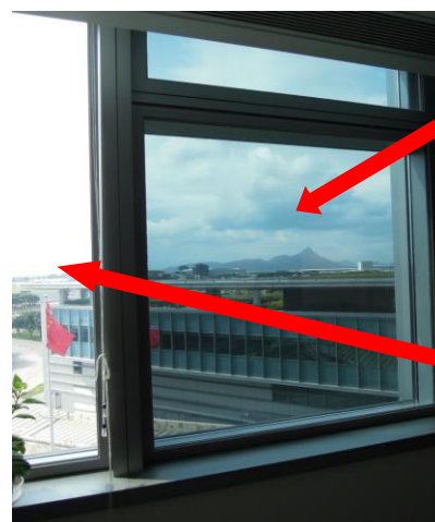
圖 5-3：玻璃窗貼上隔熱膜，使辦公地方免受太陽光照射的例子。
