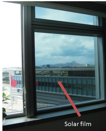
圖 5-12：在適當位置貼上隔熱膜，以阻隔太陽光和熱能
