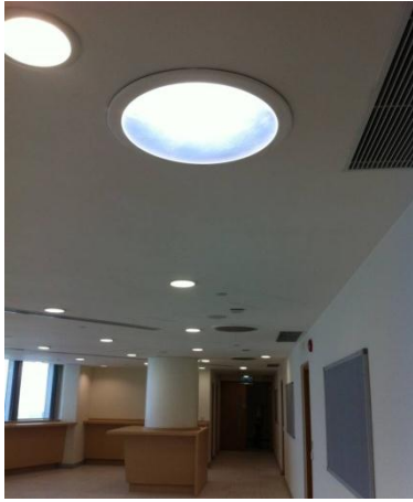
圖 5-1：空管大樓天台的日光導管(仰視圖)
