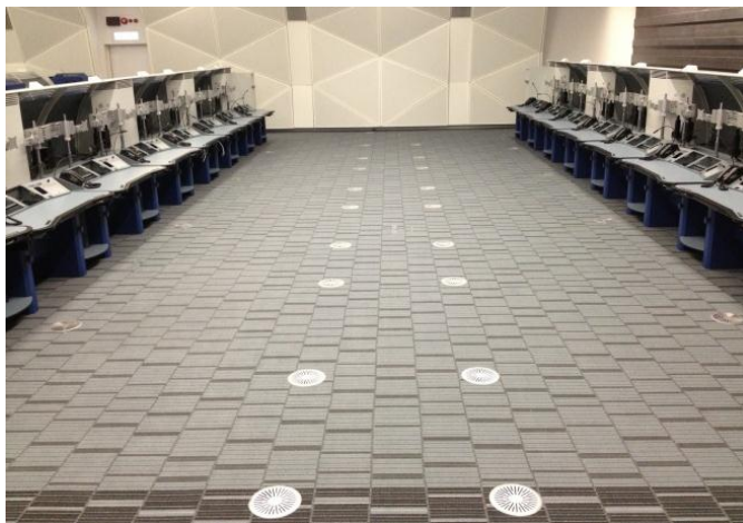
圖 5-6：設備和工作人員各有獨立的空氣調節設備
