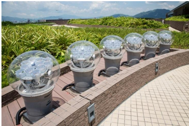
圖 5-2：光導太陽光收集裝置(置有追蹤功能)
