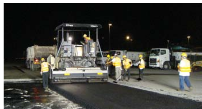
主要滑行道刨鋪工程。 Major Taxiways Resurfacing Works.
