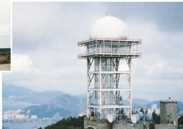
^ 位於筆架山的進場二次監察雷達站 Beacon Hill Approach Secondary Surveillance Radar Station
