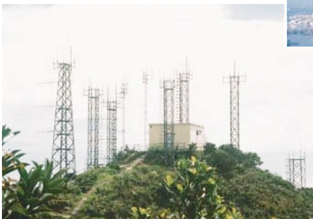
^ 民航處於太平山頂的甚高頻無線電站 CAD VHF Radio Site at Victoria Peak
