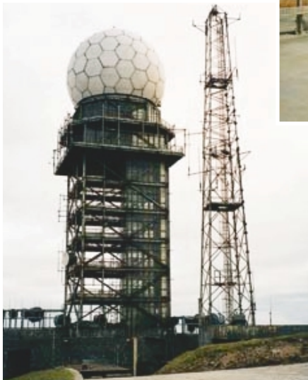
^ 位於大帽山的航站管制區雷達站 Tai Mo Shan Terminal Area Radar Station
