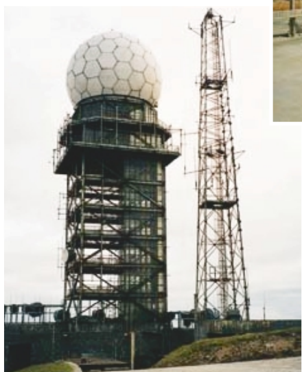
^ 位於大帽山的航空管制區雷達站 Tai Mo Shan Terminal Area Radar Station
