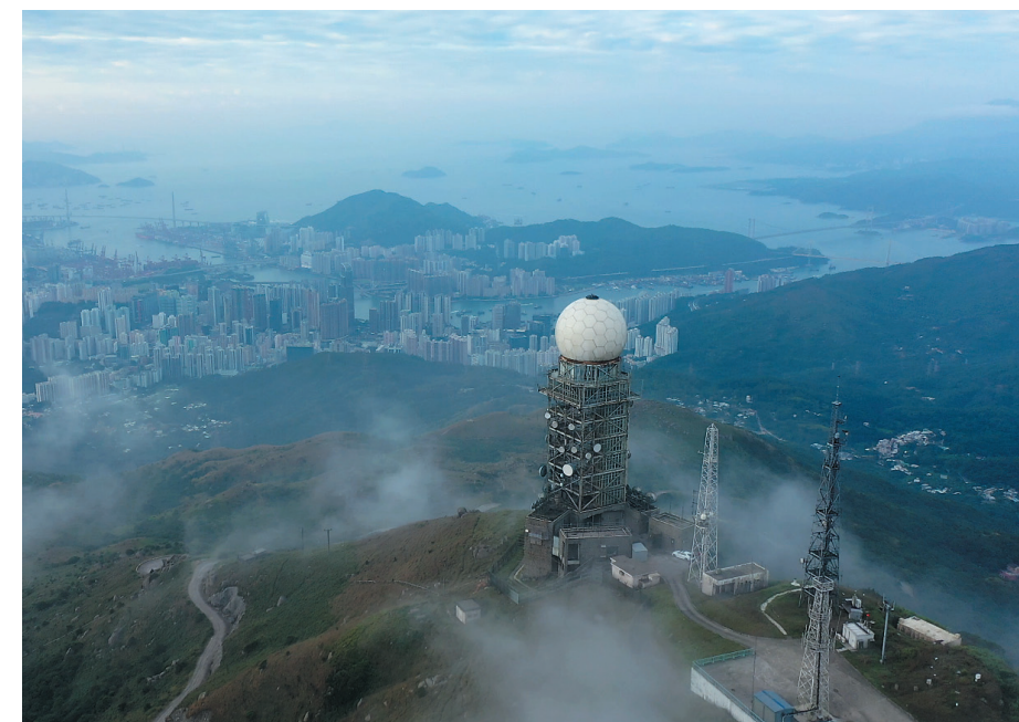
大帽山終端區雷達站。 Tai Mo Shan Terminal Area Radar Station.
