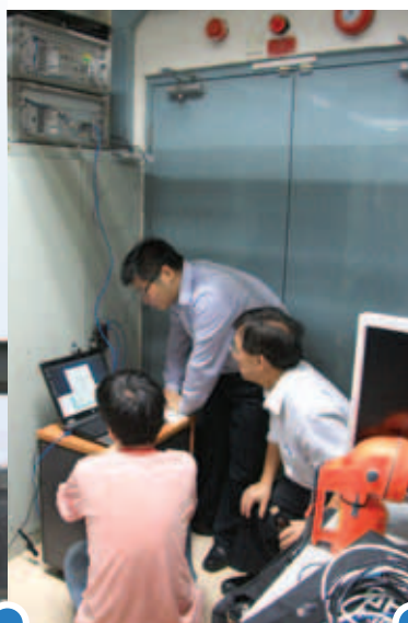
在大帽山雷達站安裝和測試廣播式自動相關監察地面站。 Installation and testing of ADS-B ground stations at Tai Mo Shan Radar Station.
