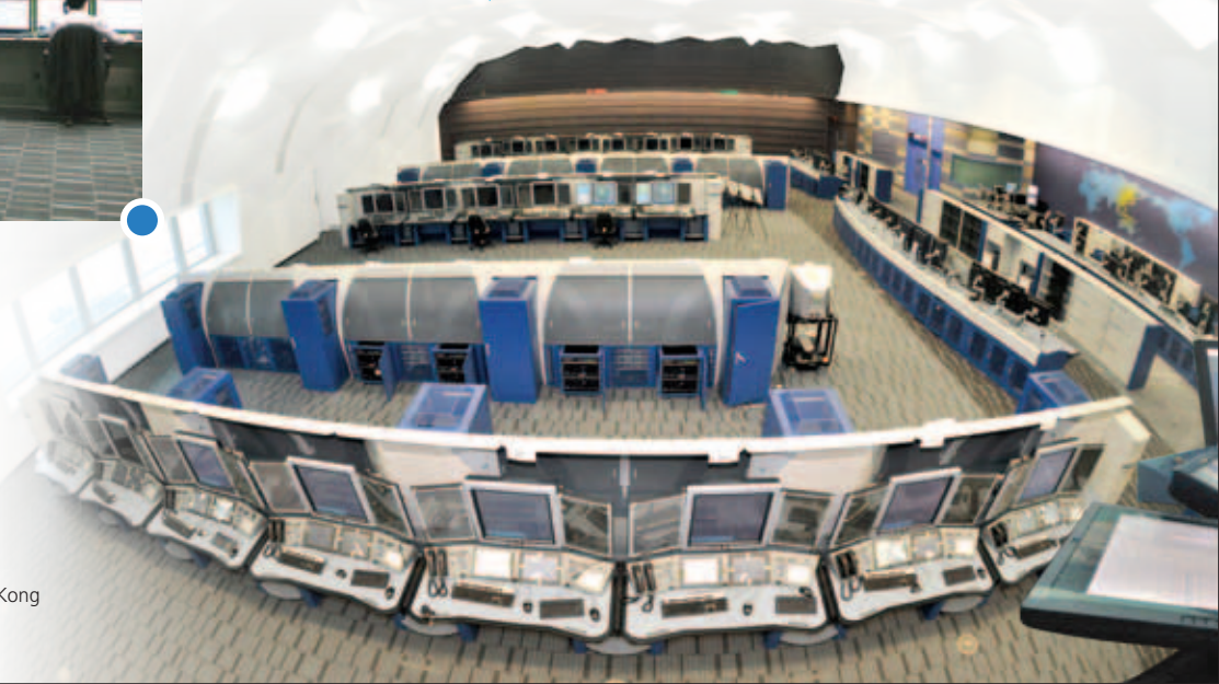
民航處總部航空交通管制中心新安裝的航空交通管理系統。 A new Air Traffic Management System is installed at CAD Headquarters' ATCC.
