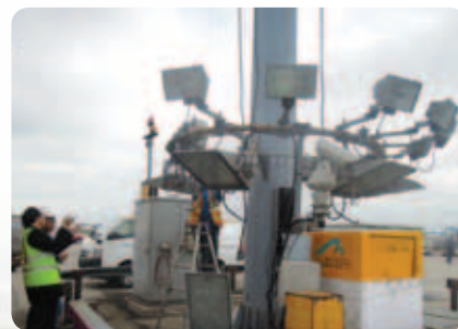
機場安全標準部人員巡察停機坪照明燈維修工作。 APSD officers inspect high mast lights maintenance works at the apron.
