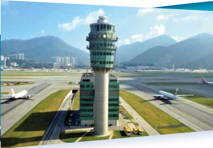
航空交通控制中心及塔台 Air Traffic Control Centre and Tower
