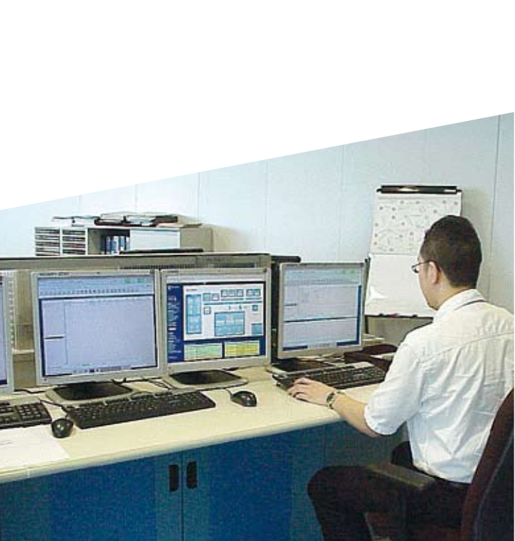
民航處人員測試新航空交通服務訊息處理系統。 Staff testing the new AMHS operator position.
