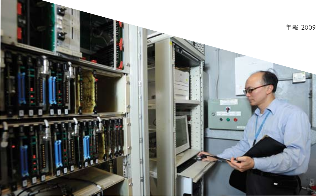
航空交通管理標準組同事正進行安全監督工作。 Staff from ATMSO conducts safety inspection.
