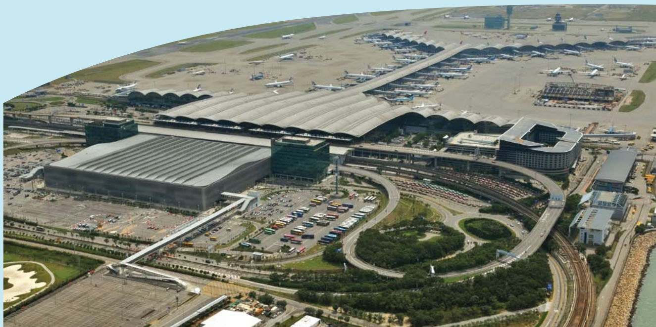
香港國際機場。 Hong Kong International Airport.
