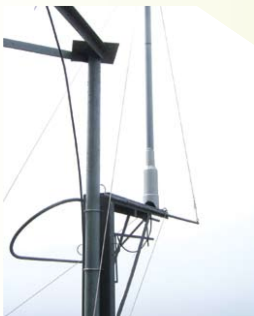
在大帽山所安裝的廣播式自動相關監察儀器測試系統的天線組件。 ADS-B Trial System at Tai Mo Shan.
