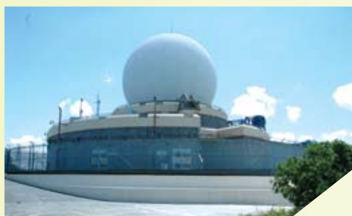
位於沙洲的進場監察雷達站。 Sha Chau Approach Surveillance Radar Station.
