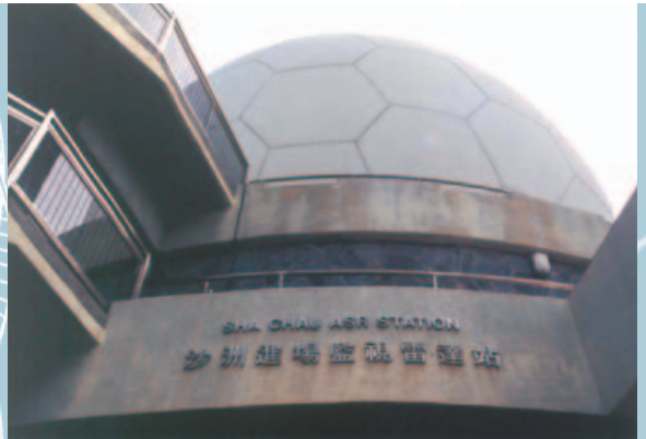
位於沙洲的進場監視雷達站。 The Approach Surveillance Radar Station at Sha Chau.
